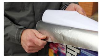
Placez Asphalt Art au bon endroit et commencez par poser le film sans film protecteur sur le sol à l'aide d'un rouleau
